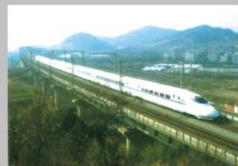
中铁电气化局
